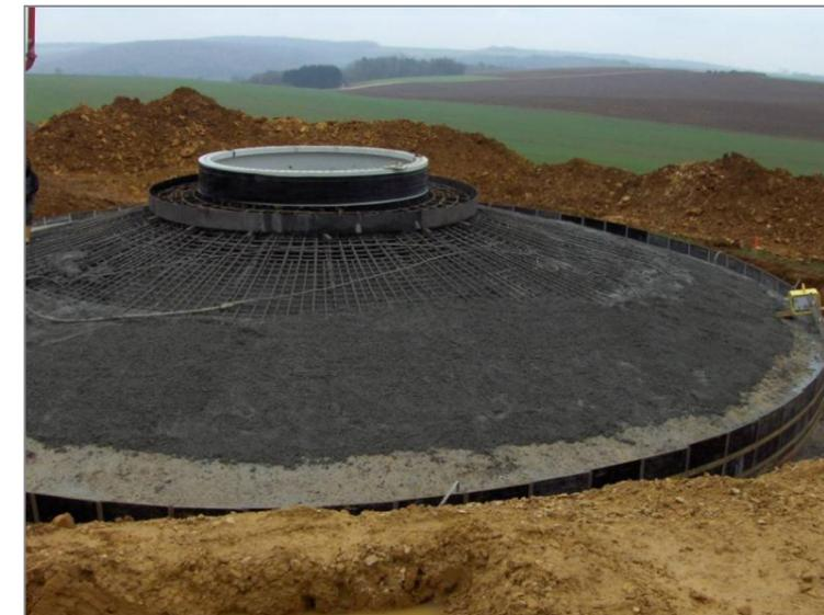
Figure 3 : Exemple de ferrailage en radier pour une éolienne (chantier en cours)
